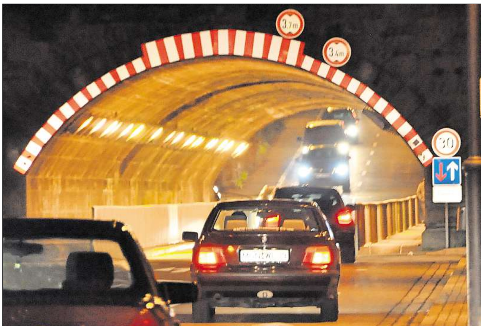
Seit einigen Wochen ist der Tunnel Marienstraße wieder hell beleuchtet. Die Sicherheit braucht aber sehr viel Strom. Bis Mitte Februar wollen die Stadtwerke daher alle Lampen auf LED umgerüstet haben. Das spart pro Jahr rund 260 000 Kilowattstunden Elektroenergie ein – Strom für gut 100 Haushalte.
