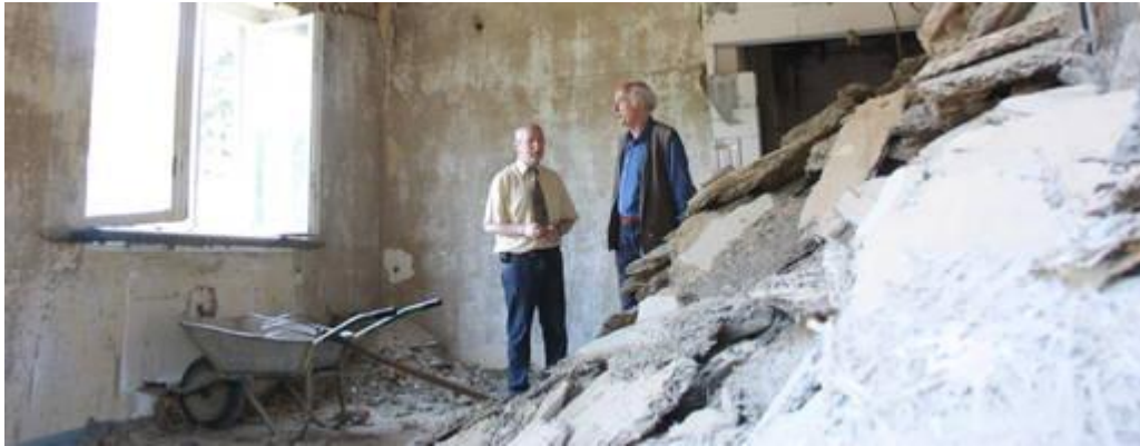
Das künftige Lehrerzimmer besteht bisher noch aus Bauschutt. Doch Michael Frankenstein (links) vom Trägerverein der privaten Förderschule hofft, dass bis Oktober die neuen Räume genutzt werden können, auch dank der Spende, die Walter Weispfenning gestern übergab. Foto: Robert Mailbeck
